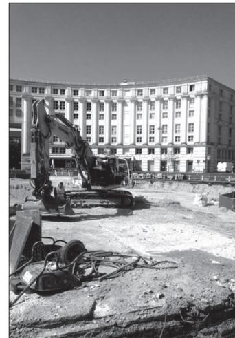
les machines ont entamé la déconstruction de cette œuvre d'art, pavé par pavé. Le trou est peu à peu comblé en partie avec du « stabilisé » (mélange sable, gravier et eau). Cette préparation du terrain devrait durer jusqu'en juillet, en vue des premières plantations de la forêt urbaine l'hiver prochain (*La Page* n°133). Cette perspective réjouit les riverains pour qui l'arrivée de verdure vaut mieux qu'un nouveau centre commercial !
