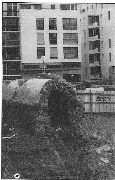
Aqueduc Médicis en cours de destruction et de morcellement sur le chantier de la Zac Alésia-Montsouris, avril 2001.
