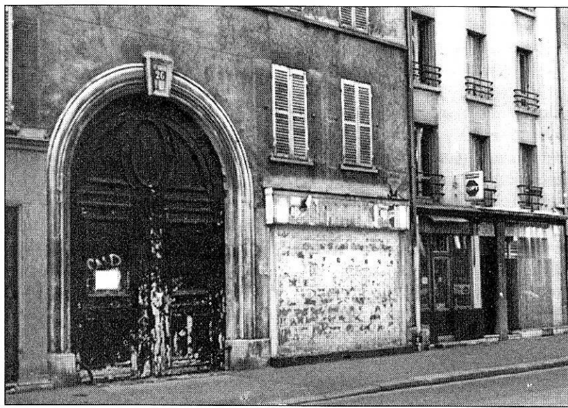
Rue de la Tombe-Issuire, les fenêtres murées attendent les sans-logis (photo : Omar Silihi)
