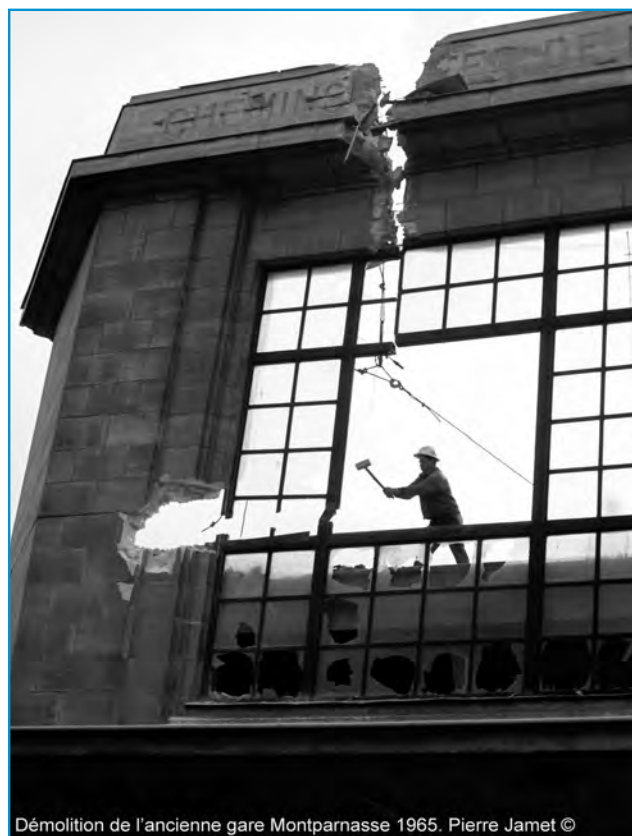
Démolition de l'ancienne gare Montparnasse 1965. Pierre Jamet ©
