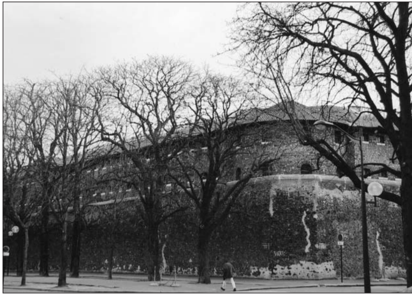
Le 14e abrite une des prisons les plus délabrées de France, la maison d'arrêt de La Santé. (PHOTO : F.H.)
